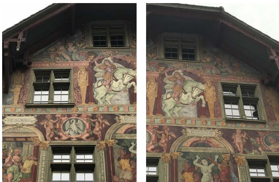
Fig. 11 : Tobias STIMMER, [Façade de la Haus Zum Ritter ], Schaffhouse, Suisse.
