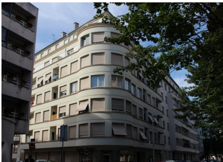
Fig. 3. Immeuble 10 rue du Saint-Gothard de Victor Hommes.
