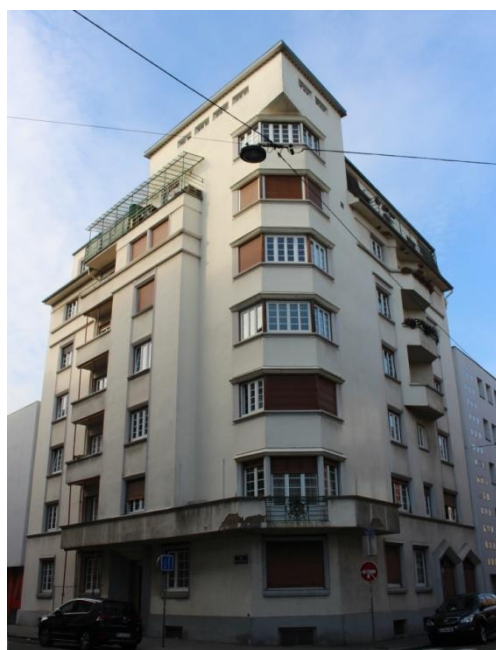
Fig. 4. Immeuble 2 rue de Bouxwiller d'Eugène Brast.
