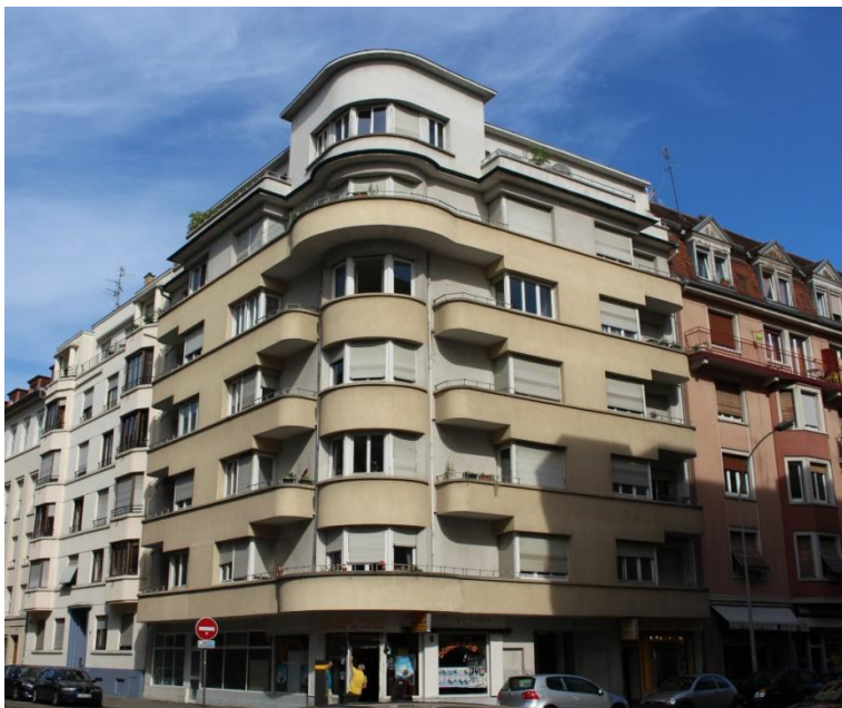
Fig. 5. Immeuble 7 rue de Berne de Tim Helmlinger.
